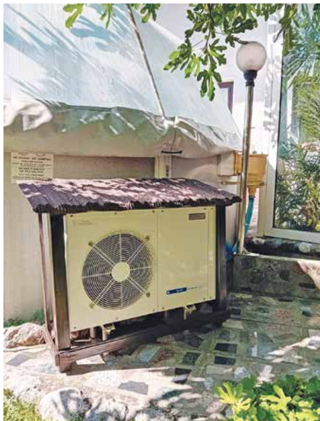
Slika 4: Manjša toplotna črpalka ogreva bazen
