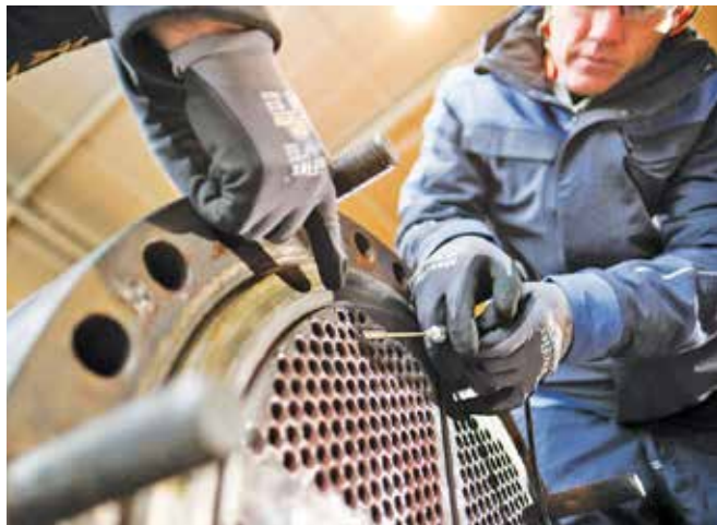
Slika 1: Metoda z vzorčevalno sondo (sniffer)
